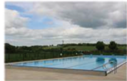
Piscine à Châteaumeillant
